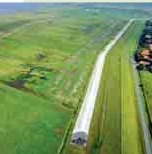
Hochwasserschutz auf hohem Niveau: Sturmflutsperrwerk (oben links) und Wellenkammer an der Containerkaje (oben rechts). Unten: Blick auf Berme und Deckwerk am Seedeich der Wurster Küste.
