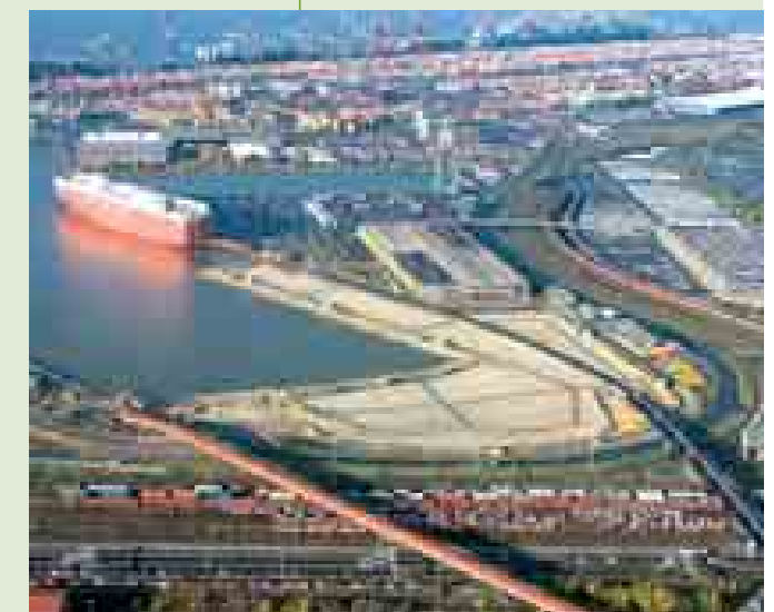
Spundwandstahl, Sand und Hafenschlick: Beim Bau von neuen Liegeplätzen und Landflächen am Osthafen zogen die Planer alle Register.
