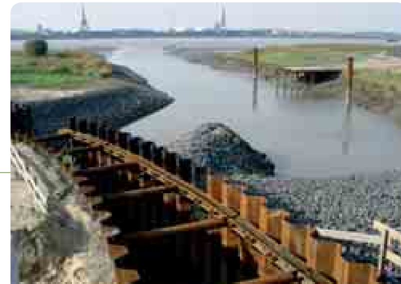
Ein Bollwerk schützt vor Hochwasser und Sturmflut: Blick auf die Baustelle des Sturmflutsperrwerks.
