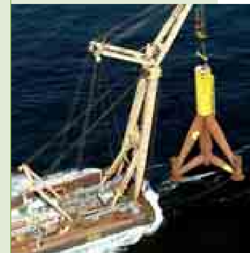
Transport einer dreibeinigen Fußkonstruktion (Tripod) zum Einsatzort in der Nordsee.
