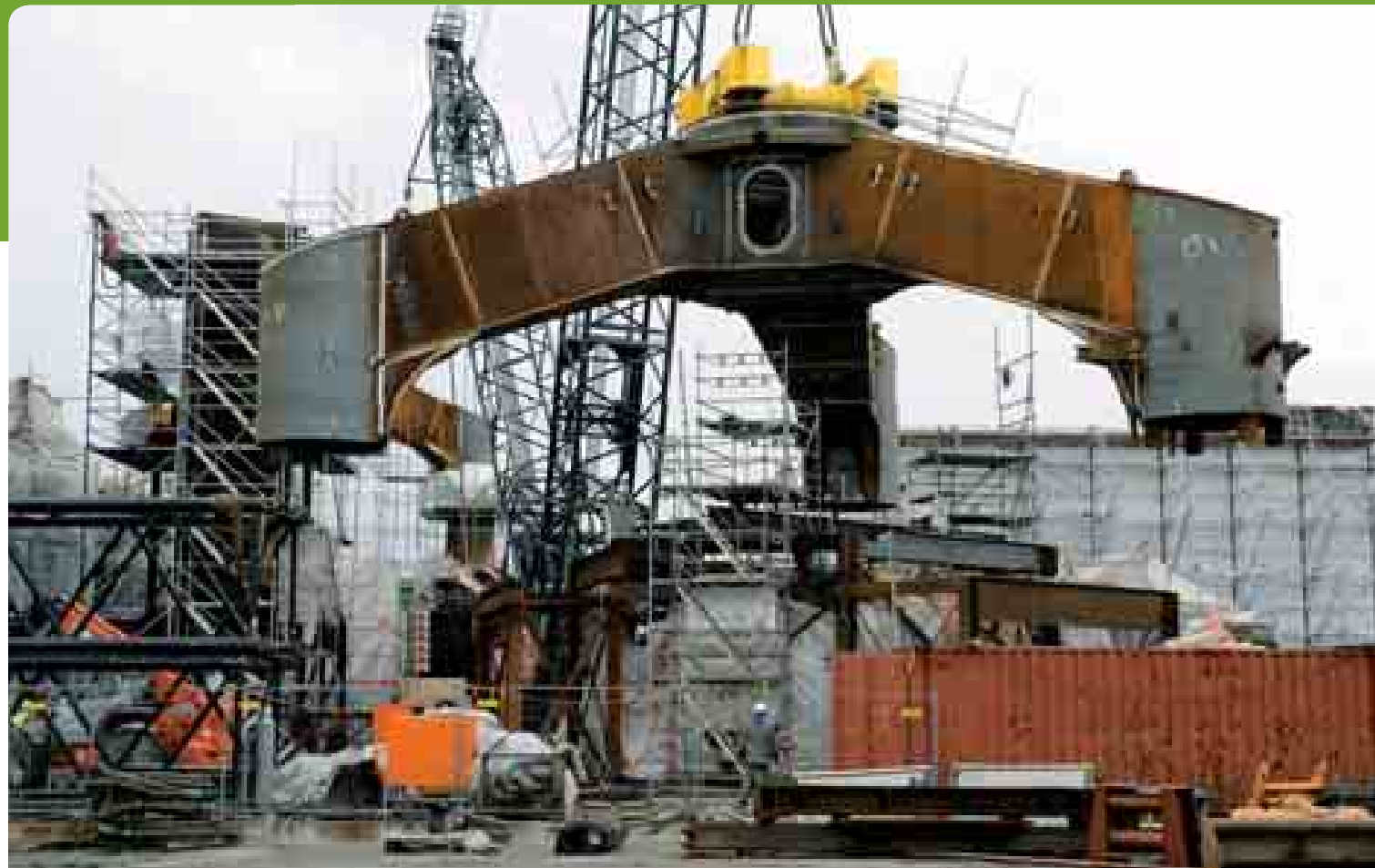
In Bremerhaven gebaut: Unterwasserfundament für den ersten deutschen Offshore-Windpark alpha ventus.
