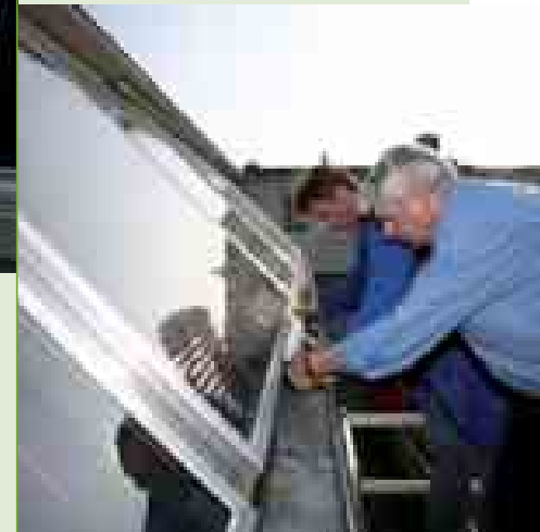
Handwerker montieren die neue Fotovoltaik-Anlage.
